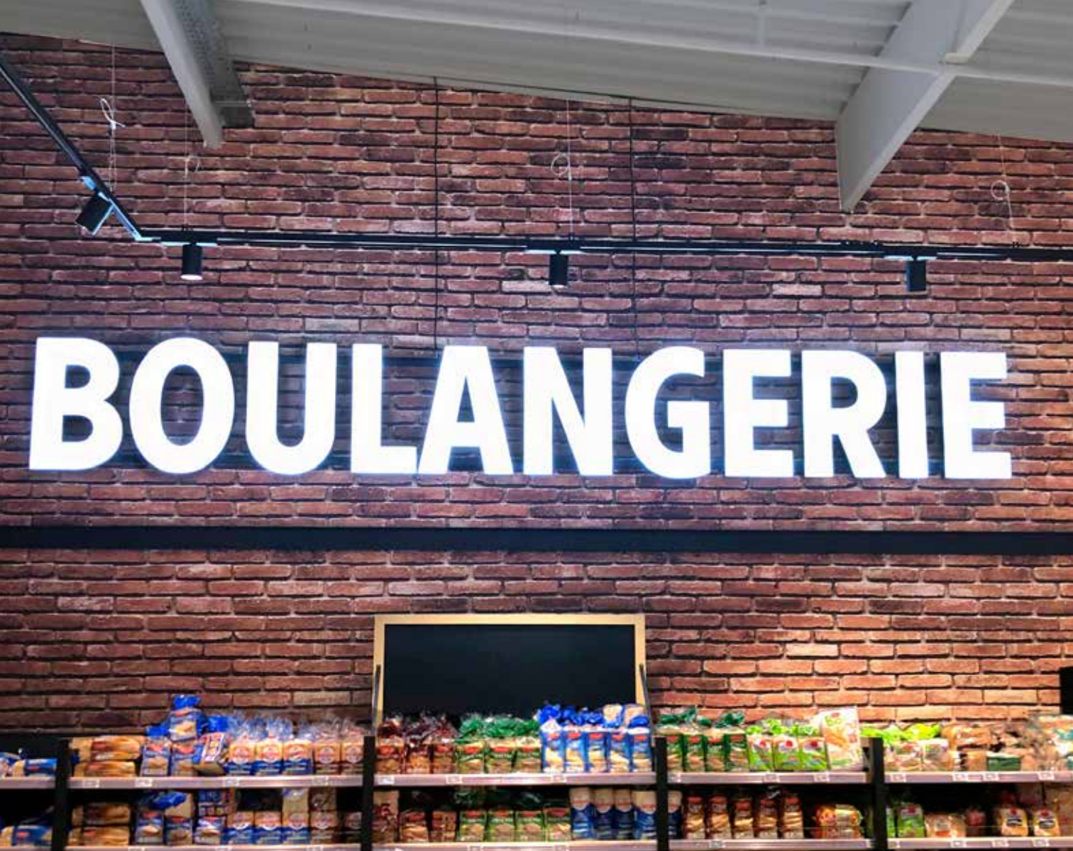
Décor mural impression sur PVC motif briques. Enseigne lettres boîtiers lumineuses montées sur lisse.
